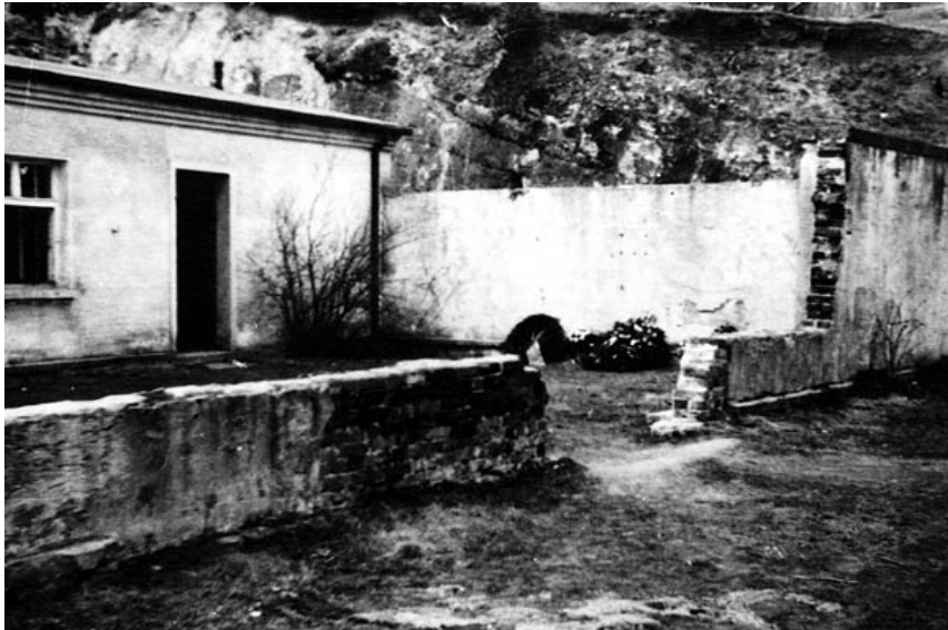
Reste der Hinrichtungsstätte im KZ Flossenbürg
